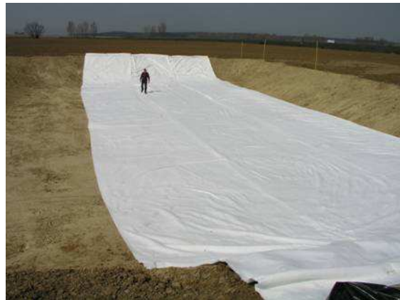
Obrázok č.2 Podkladová geotextília
